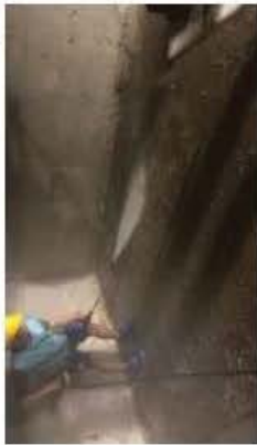
การทำความสะอาดผนังด้วยปืนฉีดน้ำแรงดันสูง
