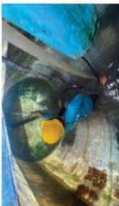
การทำความสะอาดภายในถังด้วยปืนฉีดน้ำแรงดันสูง
