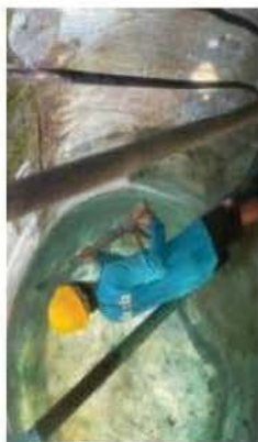
การทำความสะอาดภายในถังด้วยปืนฉีดน้ำแรงดันสูง
