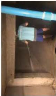
การดันและสูบลูกบอลออกจากถัง
