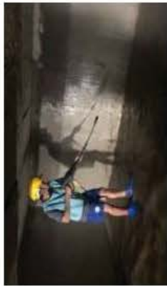
การดันและสูบลูกบอลออกจากถัง
