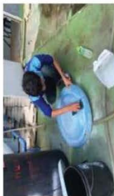
การเก็บกวาดตะกอนภายในถัง
