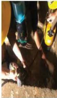
การทำความสะอาดพื้นด้วยปืนฉีดน้ำแรงดันสูง
