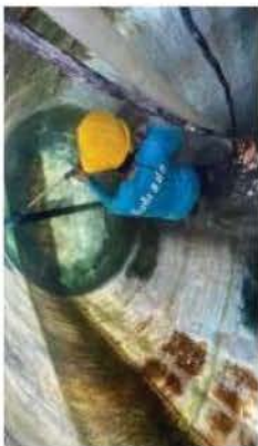
การทำความสะอาดภายในถังด้วยปืนฉีดน้ำแรงดันสูง
