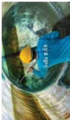
การทำความสะอาดภายในถังด้วยปืนฉีดน้ำแรงดันสูง
