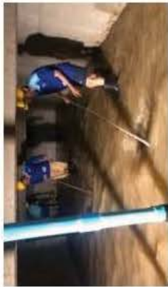
การดันและสูบลูกบอลออกจากถัง
